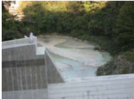
中和事業により変色した湯川（品木ダム付近）
