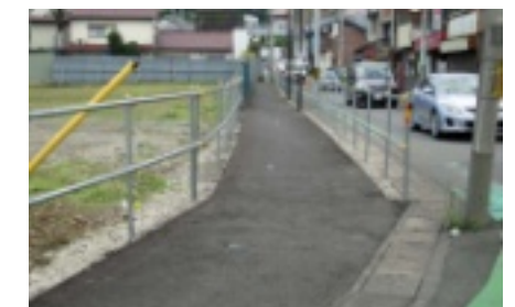
橋歩と道16が号設の置間さのれ道た路霞
