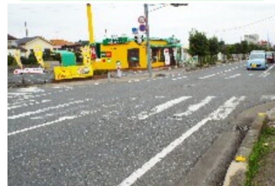
(藤沢中央通り線の全体で見えにくい横断歩道)
