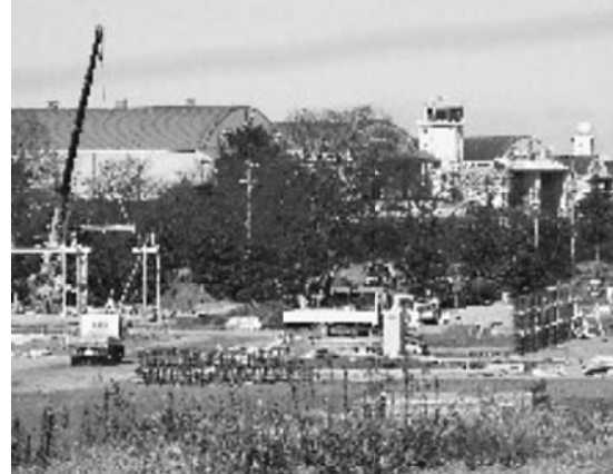
(西武線沿いの入間基地の大規模工事)
